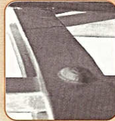
Klasszikusan kovácsolt, gombozott végű kanikával
